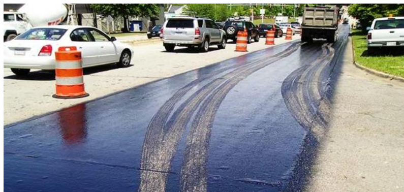
Gambar 2.2: Tack Coat Pada Pengaspalan Jalan ( Sumber Google).
