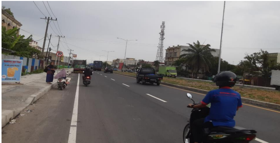
Gambar 3.3: Kondisi Jalan Kapten Sumarsono.
