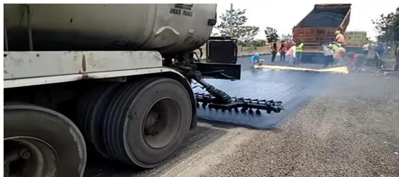
Gambar 2.1: Prime Coat pada Pengaspalan jalan ( sumber google).
