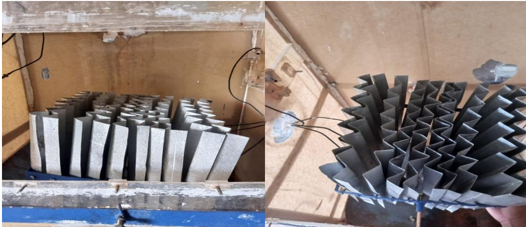
Gambar 4.18 Pemasangan fill kedalam rangka akrilik Cooling Tower
