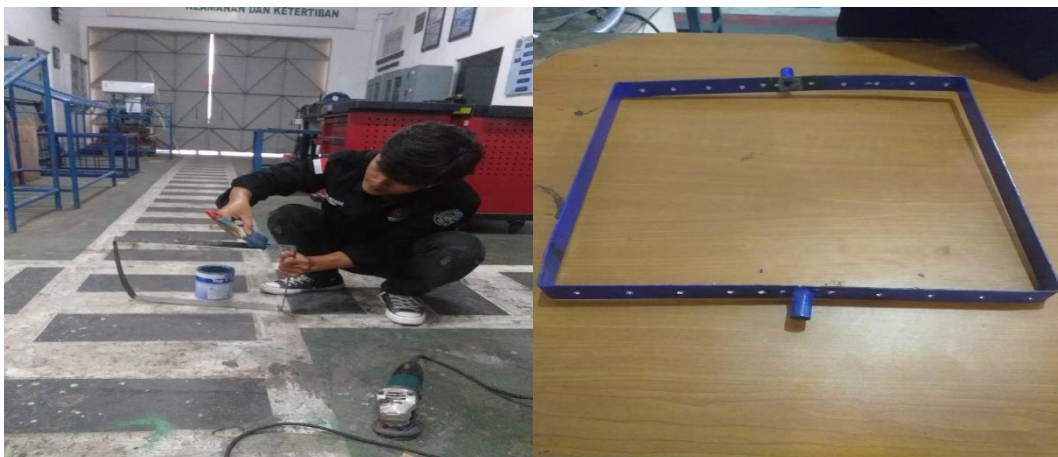
Gambar 4.9 pengecatan pada bingkai
