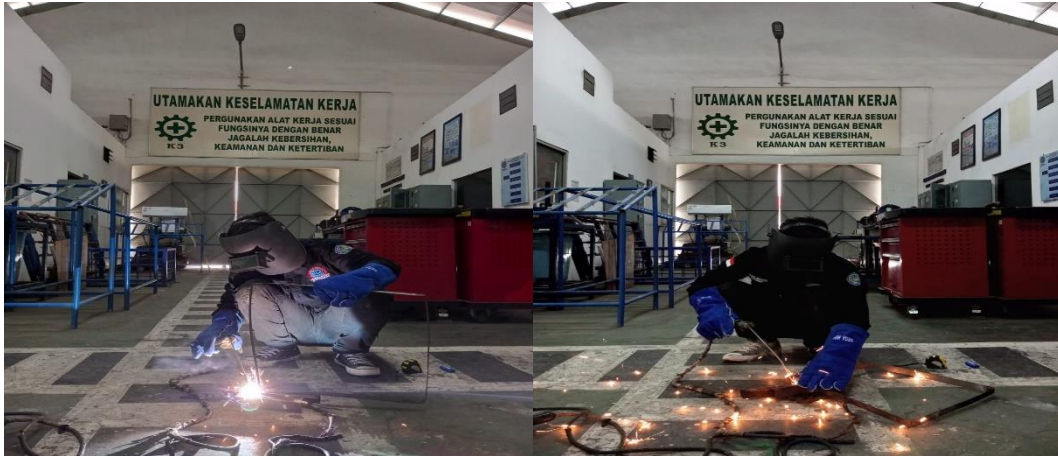
Gambar 4.6 mengelas plat strip besi yg sudah di bentuk persegi
