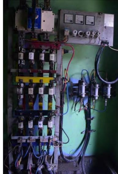
Gambar 2.11 Kubikel dan rak Tegangan Rendah pada gardu beton
