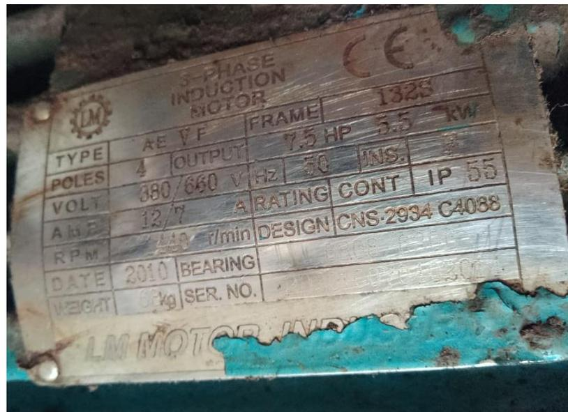
Gambar 2. 25 Spesifikasi Motoran Claybath Separator Pump
