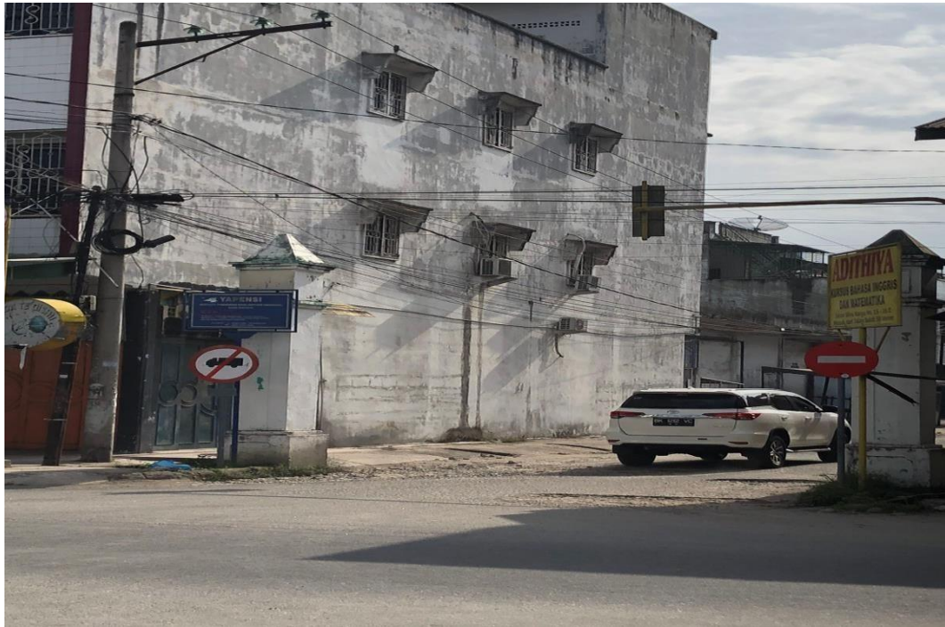
Gambar L.3 : Kondisi Rambu dan Marka Di Jalan Imam Pramuka
