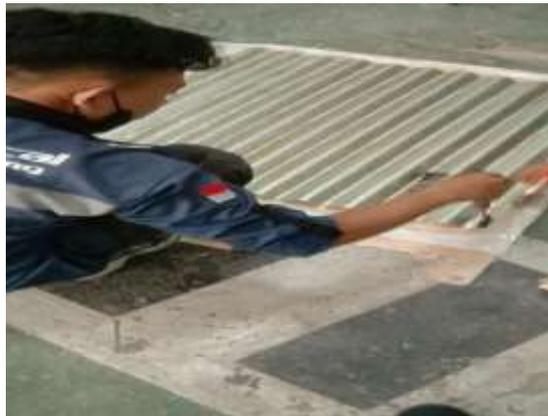
Gambar 3.13 mencampurkan resin dan katalis pada *fiberglass*
