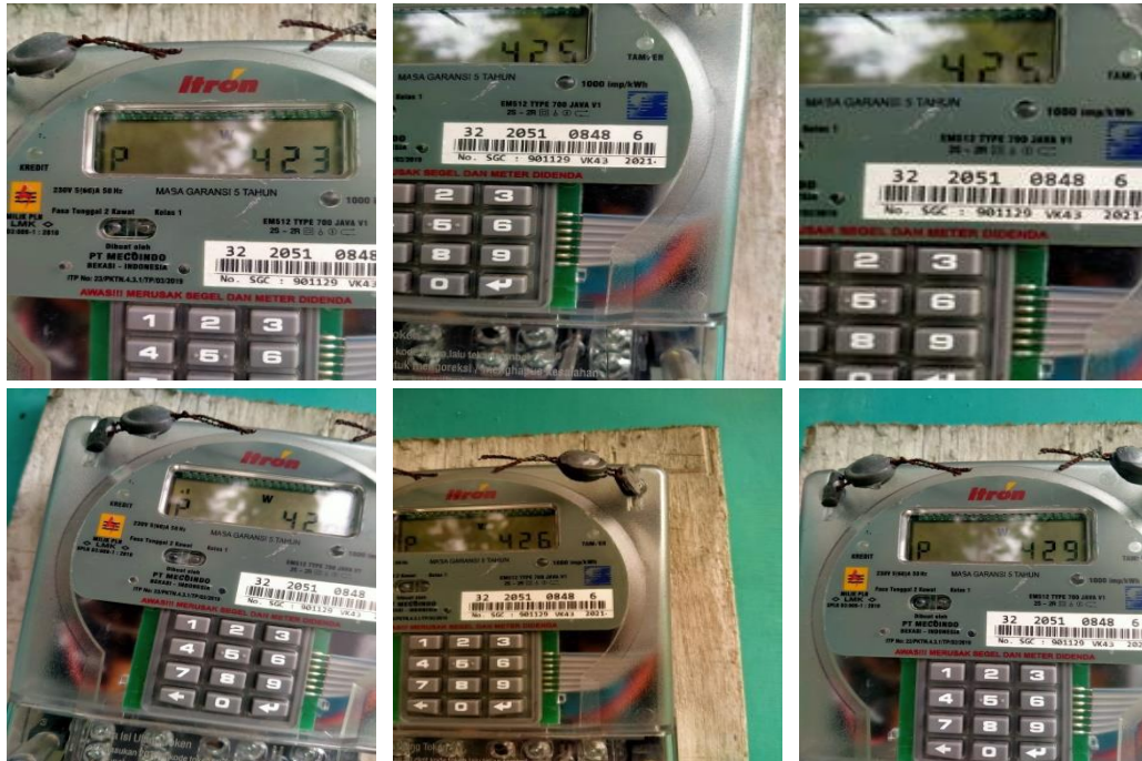
Gambar 4.11 Daya terpakai pada aerator blower
