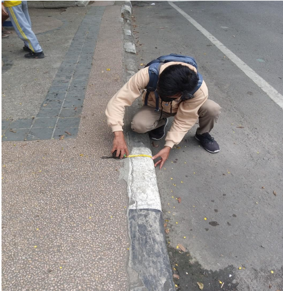
Gambar L1: Pengukuran tebal pedestrian pada jalan Dr.Sutomo, Kota Tebing Tinggi.
