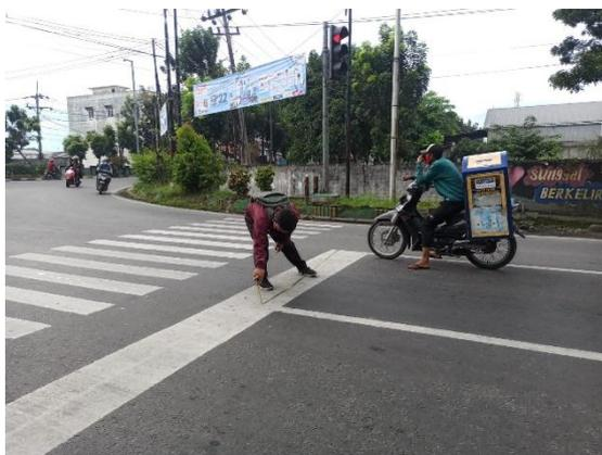
Gambar L.3: Mengukur Data Geometrik Jalan.
