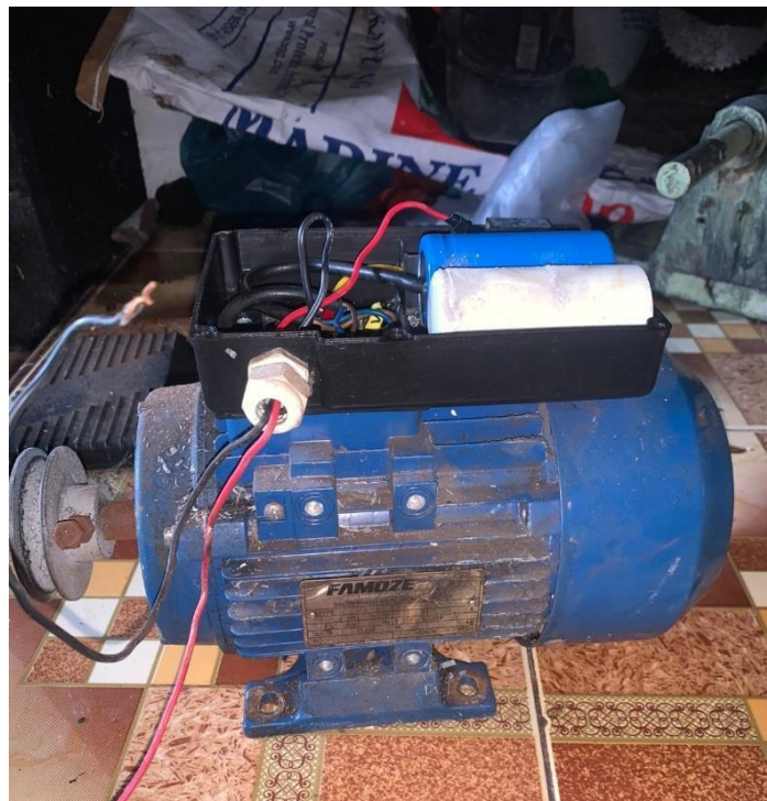
Gambar 2. Perakitan alat pada motor
