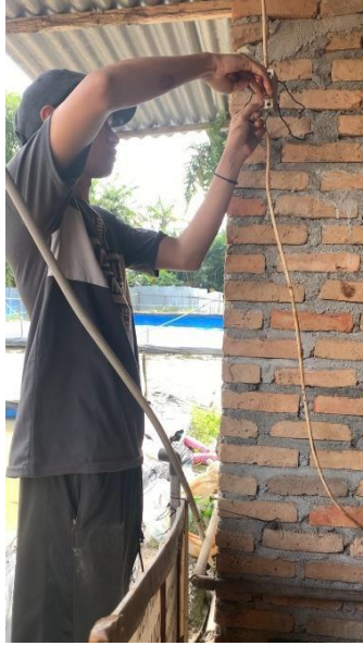
Gambar 3. 5. Pemasangan MCB Pada Sistem
