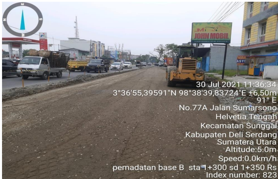
Gambar L.1: Pemadatan agregat kelas B
