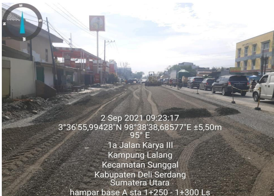
Gambar L.2: Pemadatan agregat kelas A
