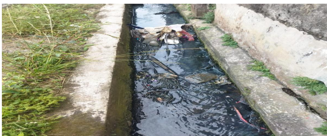
Gambar 4.6: Saluran drainase di Jalan Bajak III
