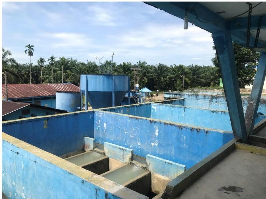
Gambar L3 : Sedimentasi atau pemisahan air tahap ke 2
