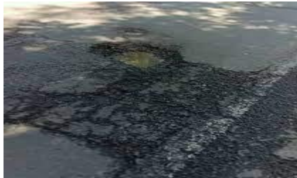
Gambar 2.10: Kerusakan Lubang.
