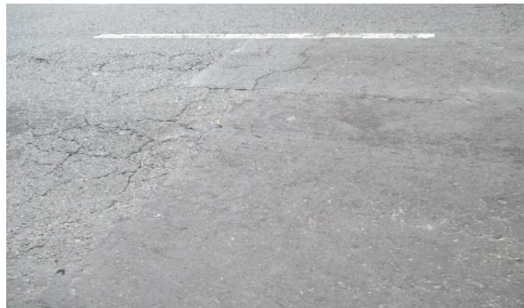
Gambar 2.3: Gmbar Retakan Halus
