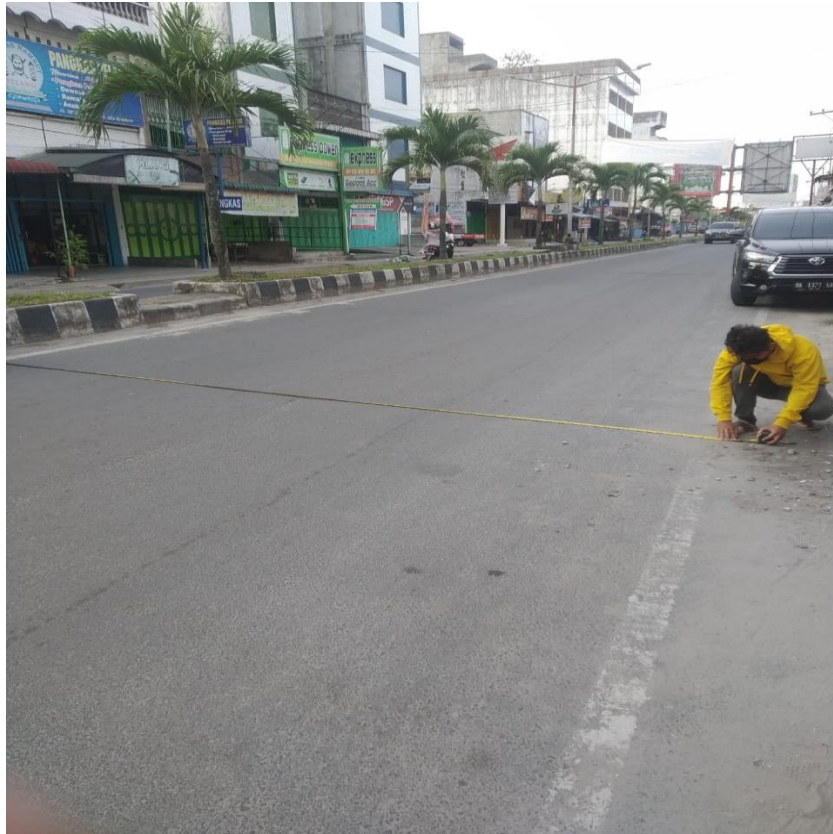
Gambar L.1: Mengukur Lebar Jalan Imam Bonjol Kota Kisaran.
