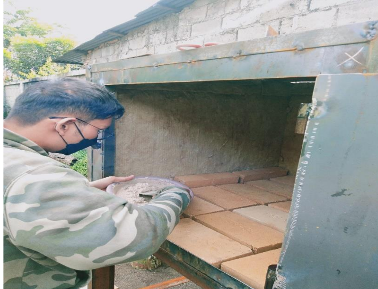
Gambar 4.7 Proses pemasangan batu tahan api
