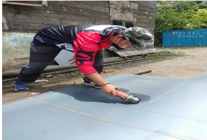
Gambar 4.3 Proses pemotongan dinding tungku
