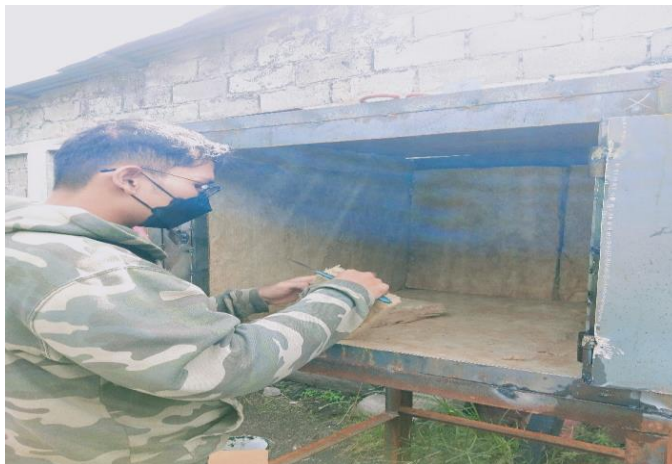
Gambar 4.6 Proses pemasangan rockwool
