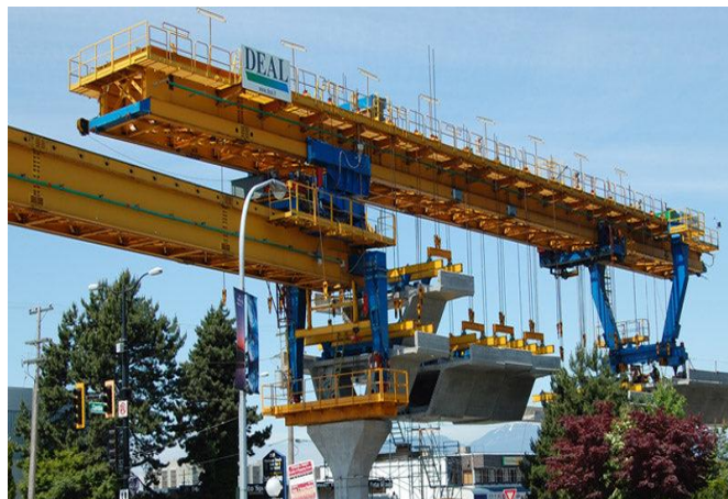
Gambar 2. 7: Metode Balanced Cantilever Erection dengan Lifting Frames
