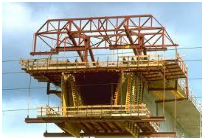
Gambar 2. 4 : Metode Balanced Cantilever dengan Form Traveller
