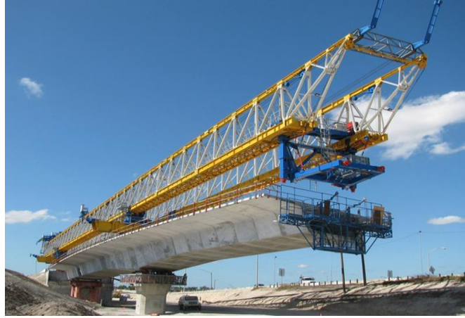
Gambar 2. 6: Metode Balanced Cantilever Erection dengan Launching Gantry
