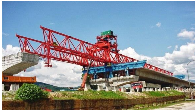
Gambar 2. 8 : Metode Span by Span Erection dengan Launching Gantry
