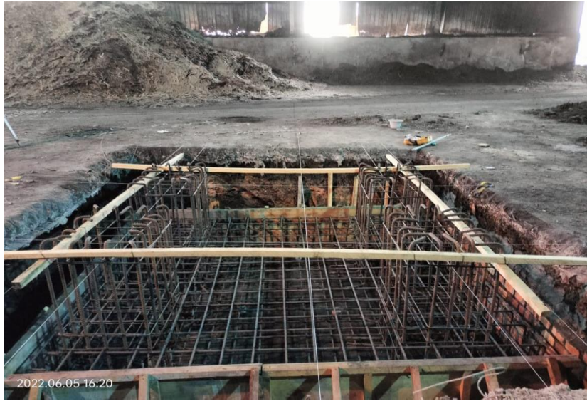
Gambar Lampiran 3: Pekerjaan Pembesian CT-1
