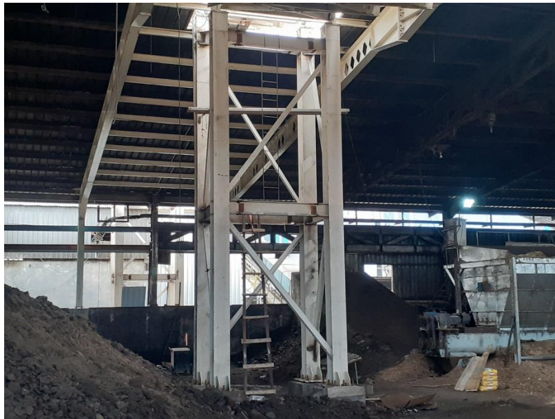
Gambar Lampiran 4: Pekerjaan Kolom Baja
