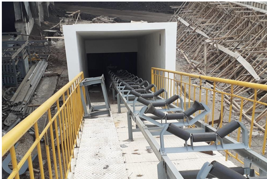
Gambar Lampiran 2: Pekerjaan Penyebrangan (Support Conveyer)
