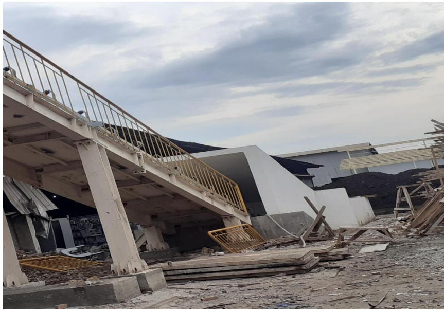
Gambar Lampiran 1: Pekerjaan Struktur Baja
