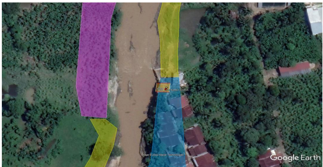
Gambar 4. 15: Lokasi Bangunan Melewati Batas Garis Sempadan.
