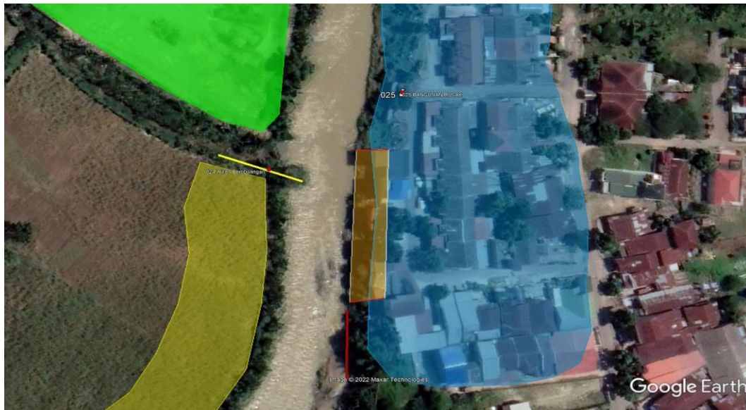
Gambar 4. 19: Lokasi Bangunan Melewati Batas Garis Sempadan.
