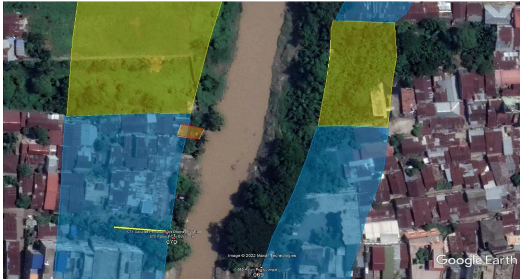
Gambar 4. 26: Lokasi Bangunan Melewati Batas Garis Sempadan.
