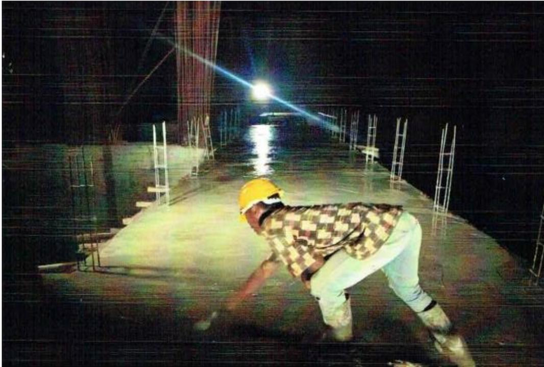
Gambar L3: Pengecoran Jembatan Bendung.
