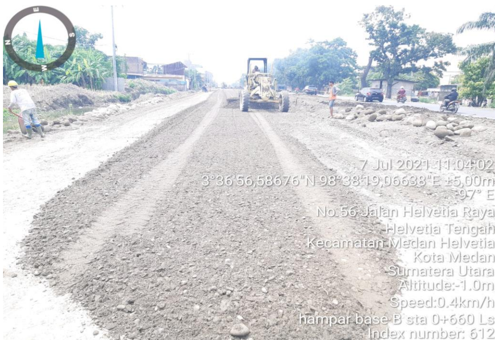
Pekerjaan Timbunan oleh Motor Grader
