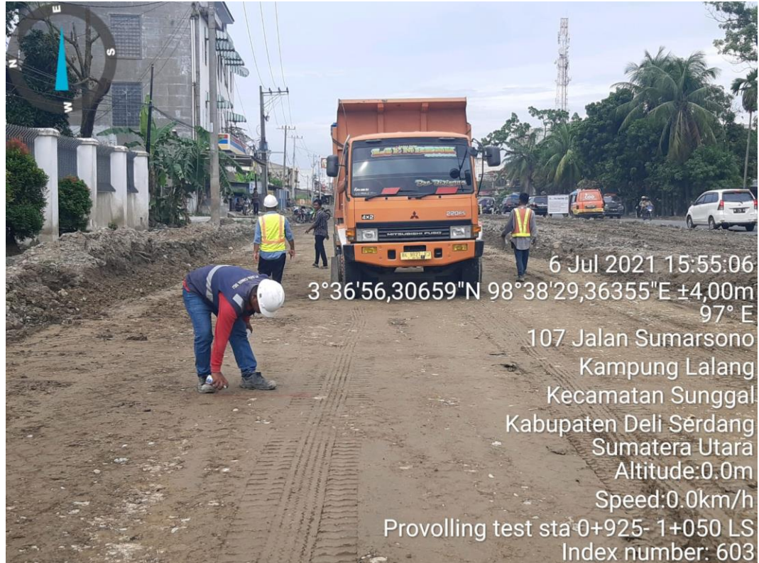
Pekerjaan Timbunan oleh Excavator
