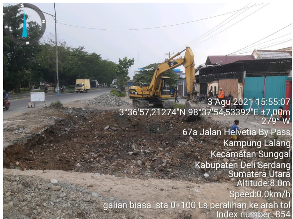
Pekerjaan Galian Tanah oleh Excavator
