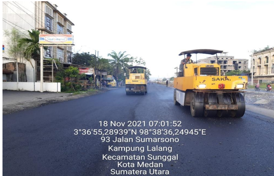
Gambar L.5: Pemasangan laston lapis antara (AC-BC)
