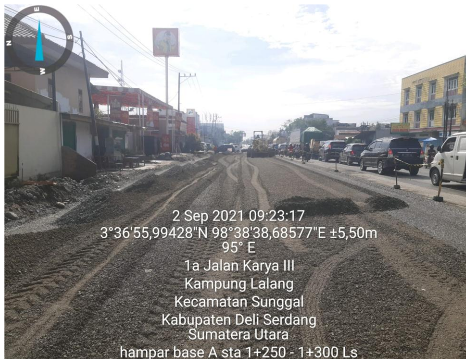
Gambar L.2: Lapisan agregat kelas A
