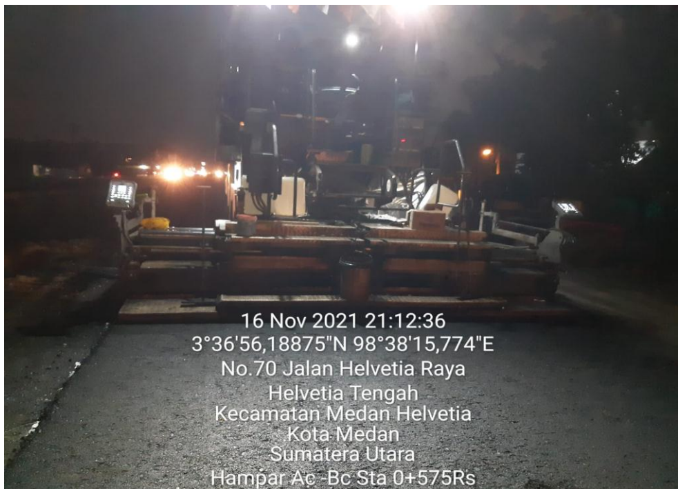
Gambar L.4: Pemadatan Laston lapis antara (AC-BC)
