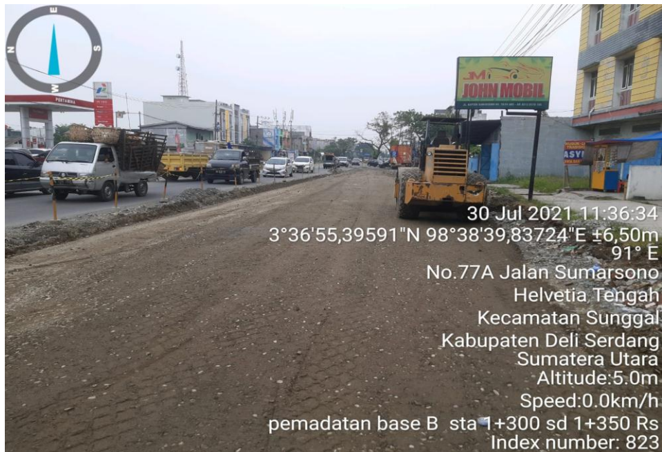
Gambar L.1: Pemadatan agregat kelas B
