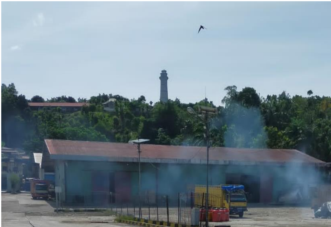
Gambar L.2: Gudang Penumpukan Pelabuhan Gunungsitoli
