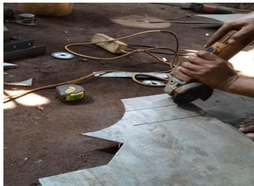
Gambar 4.61 proses pemotongan *plat stainless* penahan rumah lahar
