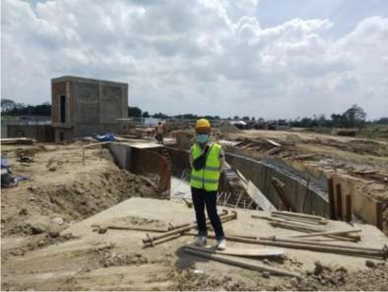
B.1 Intake sisi kiri terhubung dengan Kantong Lumpur
