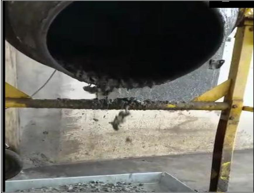
Gambar lampiran 5. Proses pengeluaran campuran beton dari mixer
