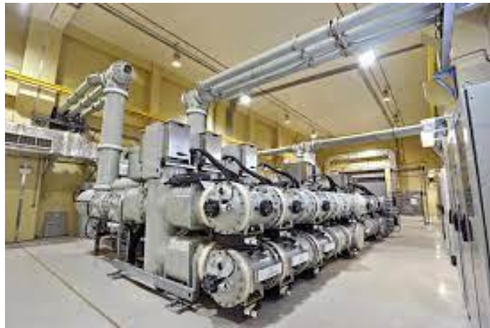
Gambar.2.2 Gardu Induk Pasangan Dalam
