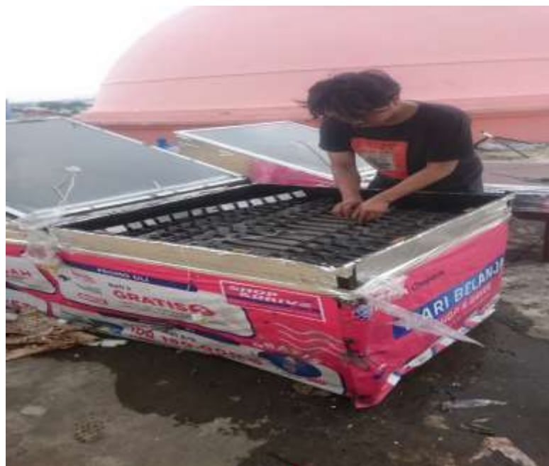
Gambar 4.6 Merapikan sirip sebelum penutupan kaca kolektor
