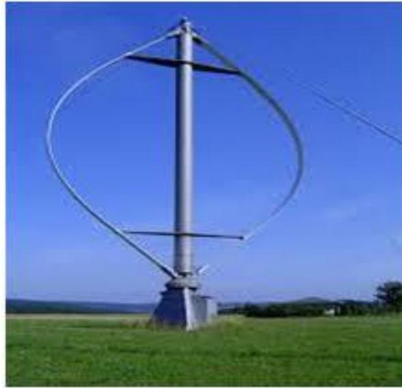
Gambar 2.2 Turbin Angin Sumbu Vertikal
