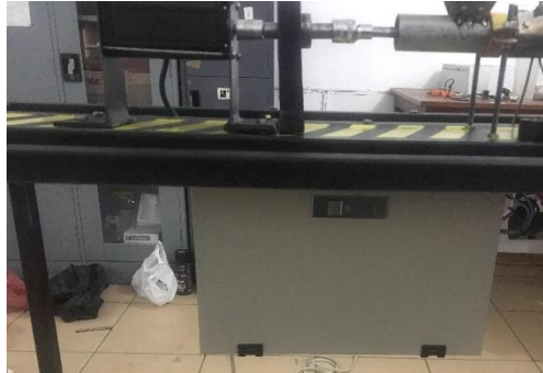
Gambar 4.59. Pemasangan Box Panel
