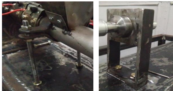
Gambar 4.47. Pemasangan Dudukan Injection dan Rumah Bearing .
