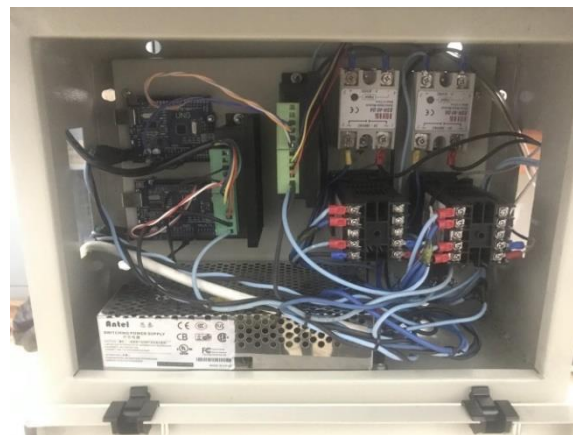
Gambar 4.62. Rangkaian Kelistrikan dalam Box
