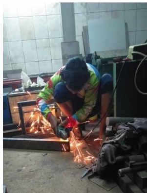
Gambar 4.15 Merapikan dan Meratakan Permukaan Dudukan Panel
