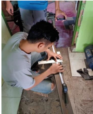
Gambar 4.12 Mengukur Panjang Besi Siku
