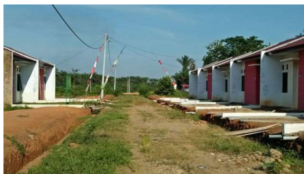
Gambar 3.3: Foto Lokasi Proyek
