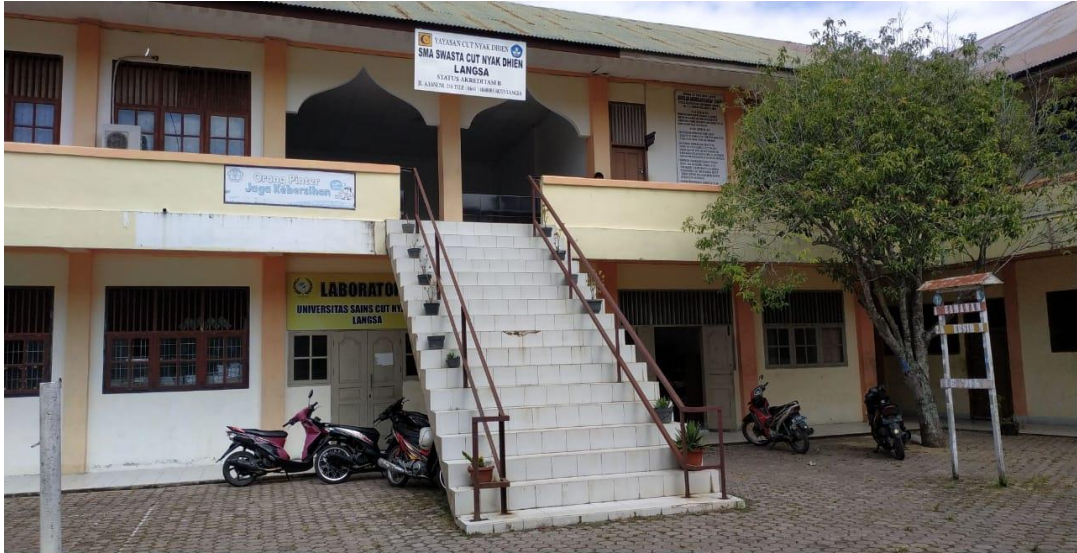
Gedung SMA Swasta Cut Nyak Dhien Langsa
