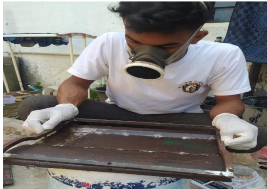
Gambar 3.31 Pemasangan Cetakan Tengah Atap
