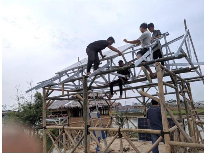
Gambar 8. Pemasangan *photovoltaic*
