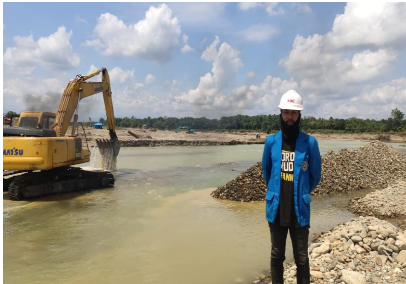
Gambar L2 : Alat berat Excavator
