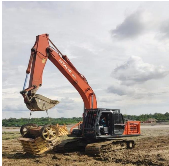
Gambar 2.1: Excavator sedang beroperasi
