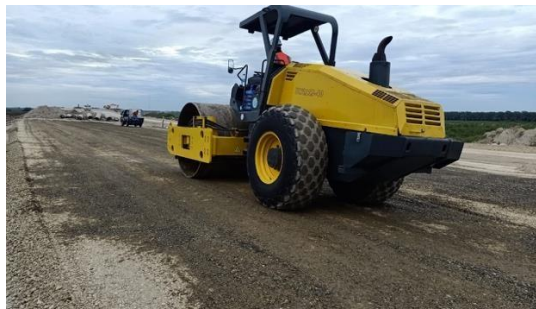
Gambar 2.5: Alat berat vibrator roller (Jalan Tol Binjai Langsa, 2021)
