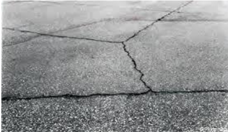
Gambar 2.8: Retak Memanjang Dan Melintang.
