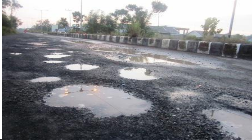
Gambar 2.10: Kerusakan Lubang.
