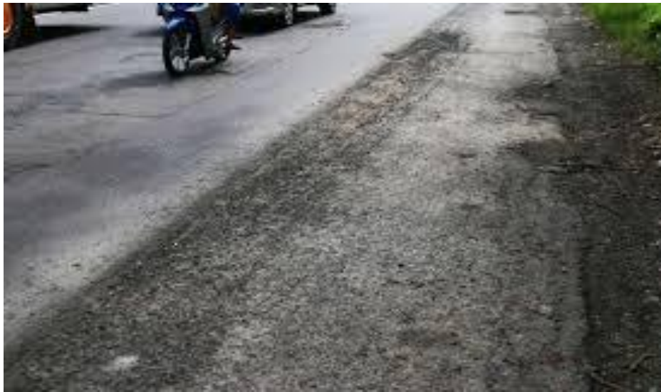
Gambar 2.13: Pelepasan Butir.
