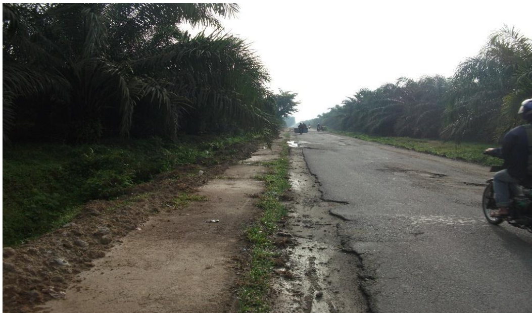
Gambar 2.5: Cacat Tepi Perkerasan.
