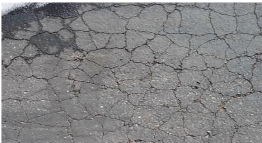
Gambar 2.2: Retak Kulit Buaya.
