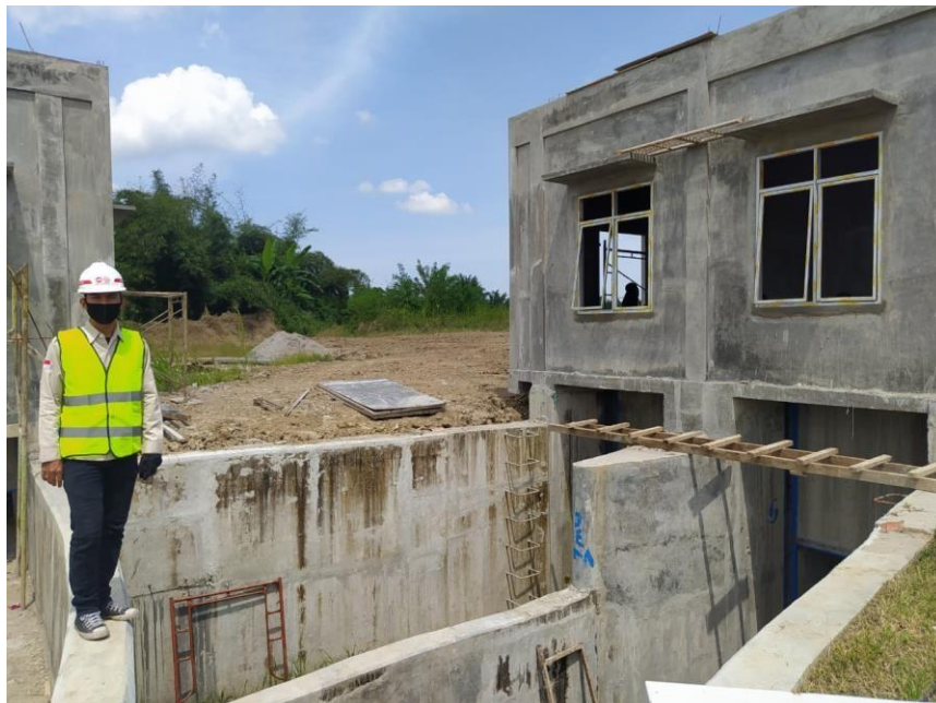
B.2 Rumah Hoist
