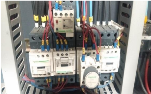
Gambar 2.10 Rangkaian Pengendali Motor Injection
