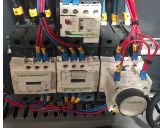
Gambar 3.7 Rangkaian Kontrol Motor Adapun settingan yang digunakan untuk menjalankan mesin sesuai agar mesin berjalan dengan baik.
