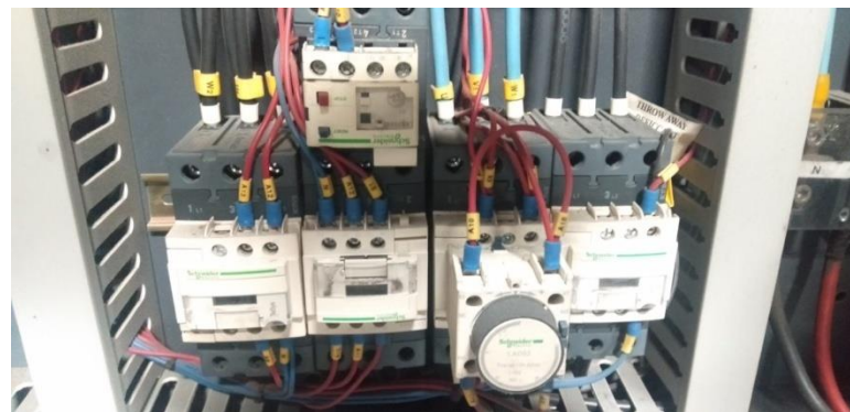
Gambar 2.10 Rangkaian Pengendali Motor Injection
