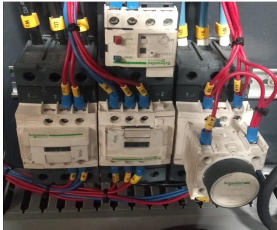
Gambar 3.7 Rangkaian Kontrol Motor
