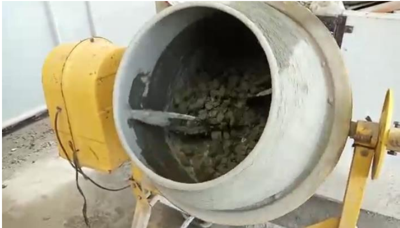
Lampiran 28 : Proses Pembuatan Adukan Beton.
