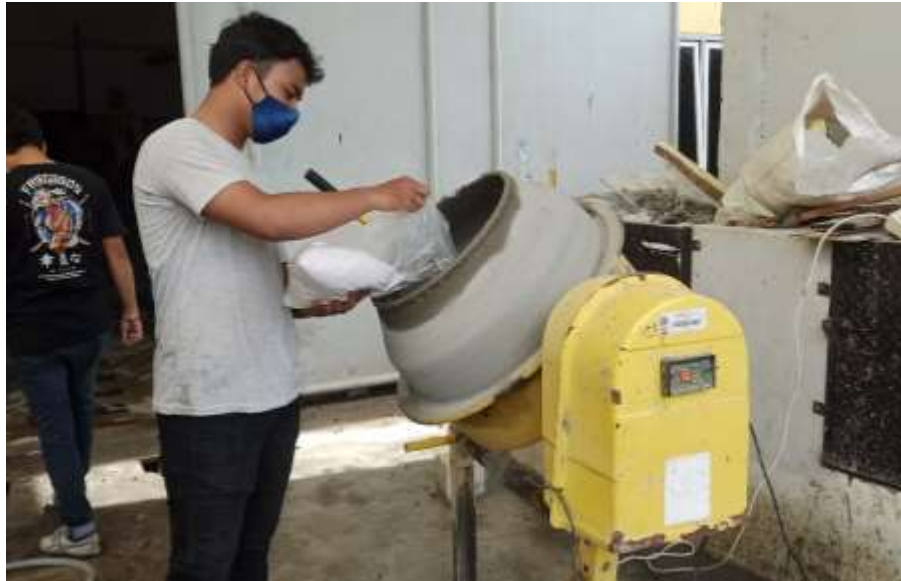
Gambar L.1: Mencampurkan Semua Bahan ke Dalam Mixer
