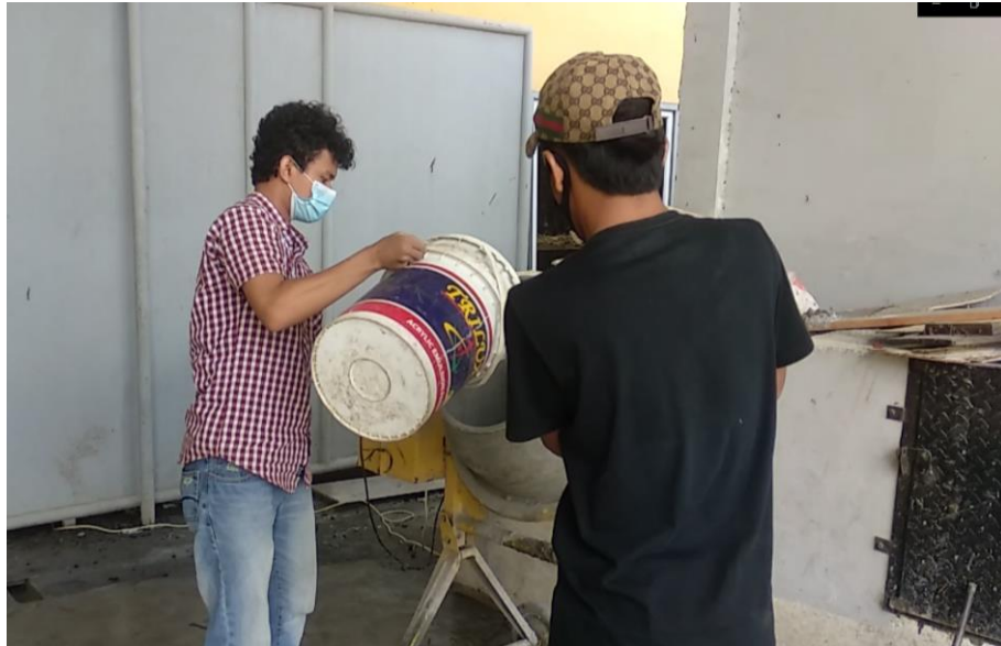
Gambar L-17: Proses Pembuatan Adukan Beton.
