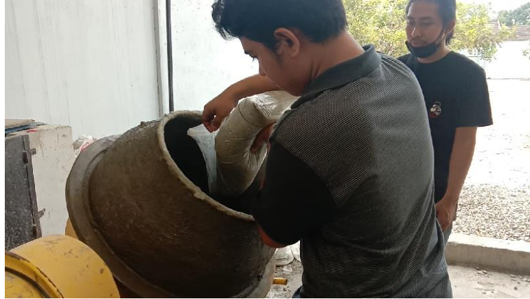
Gambar L.16: Memasukkan bahan kedalam mesin mixer .
