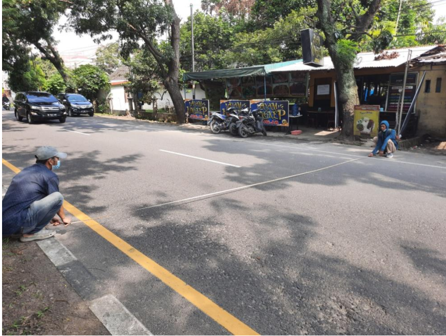
Gambar L.3: Pengukuran lebar jalan
