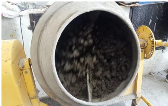
Lampiran 27. Proses Pembuatan Adukan Beton.
