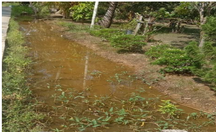
Gambar 4.5. Saluran drainase desa sennah
