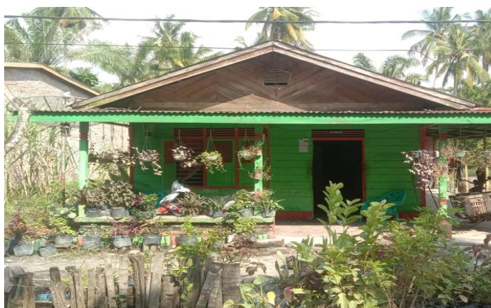
Gambar 4.3. Bangunan semi beton
