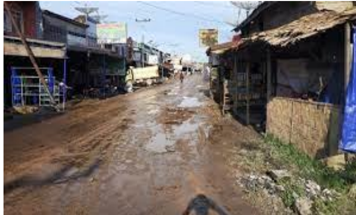
Gambar 4.7. Jalan yang rusak
