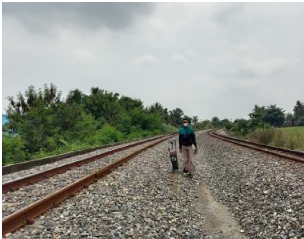
Gambar 4 : Survai Lengkung Rel Pada Titik No.7
