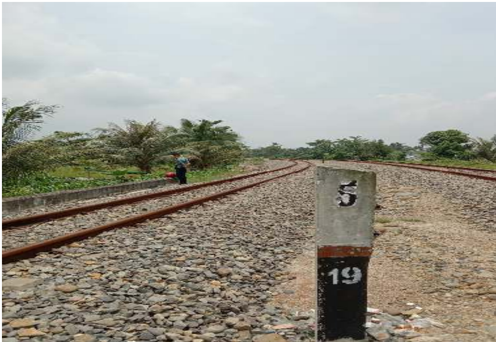
Gambar 1 : Survai Lengkung Rel Pada Titik No.5
