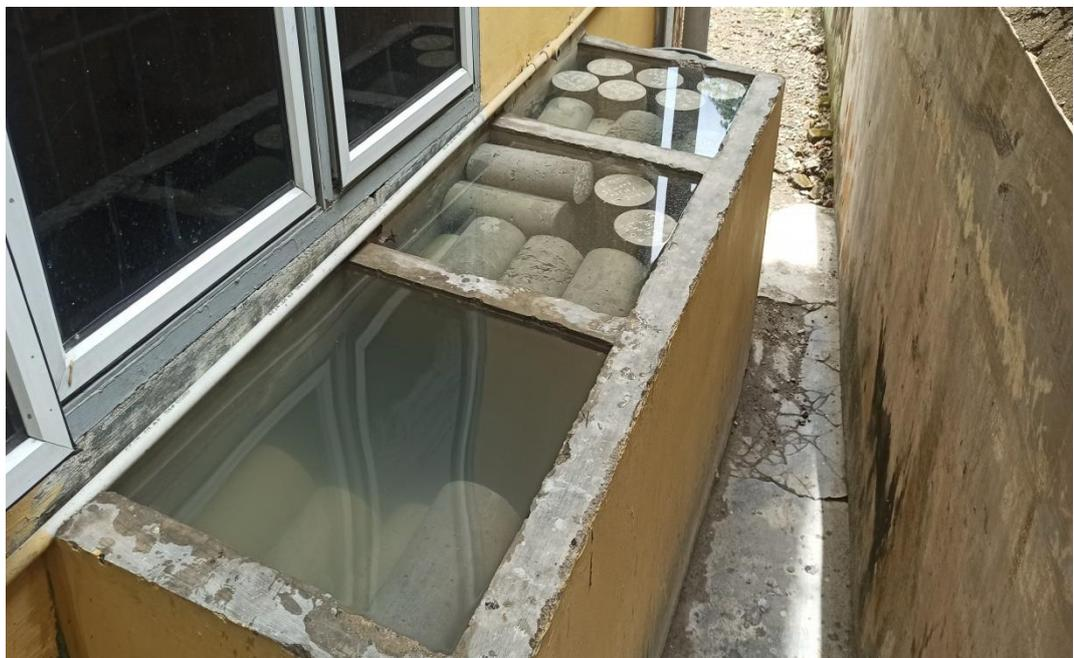
Gambar L.10 Melakukan Perawatan Beton (*Curing*) dengan Cara Merendam Beton
