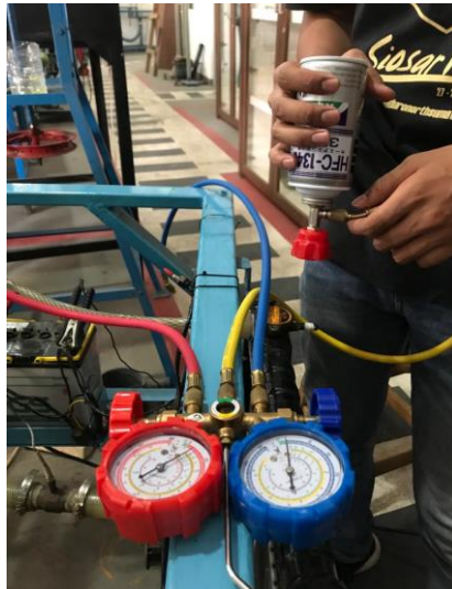
Gambar 4. 16. Pengisian Freon Pada Selang Tekanan Tinggi
